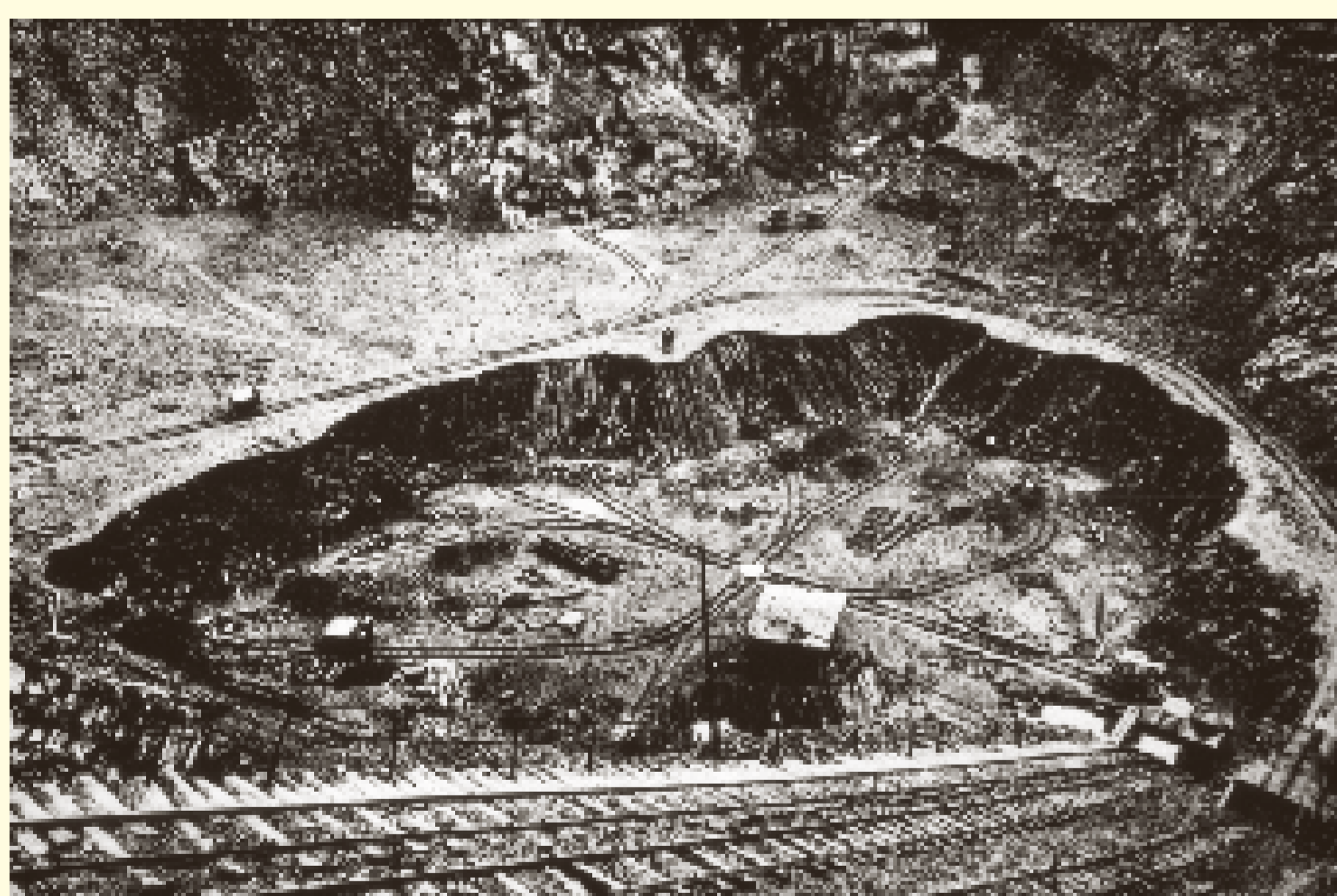
Auf der Sohle des Steinbruchs waren Schienen für Transportloren verlegt. Im Bild unten ist die Förderbahn am Hang zu sehen (vor 1914).
